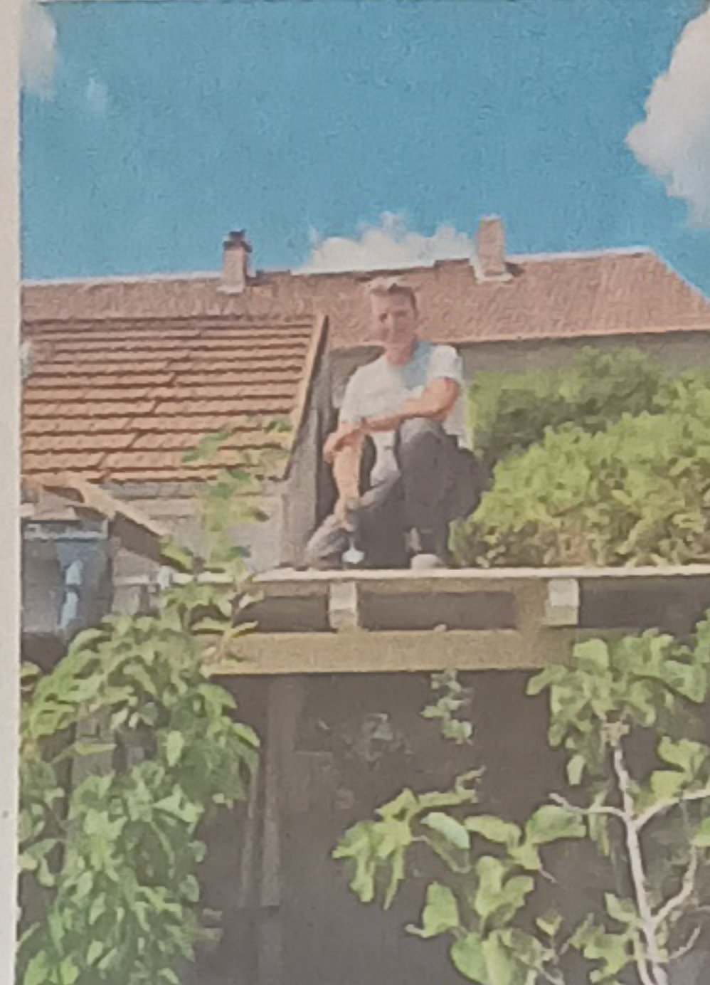
Brigade-Mitarbeiter Micha bei Terrassenarbeiten.
