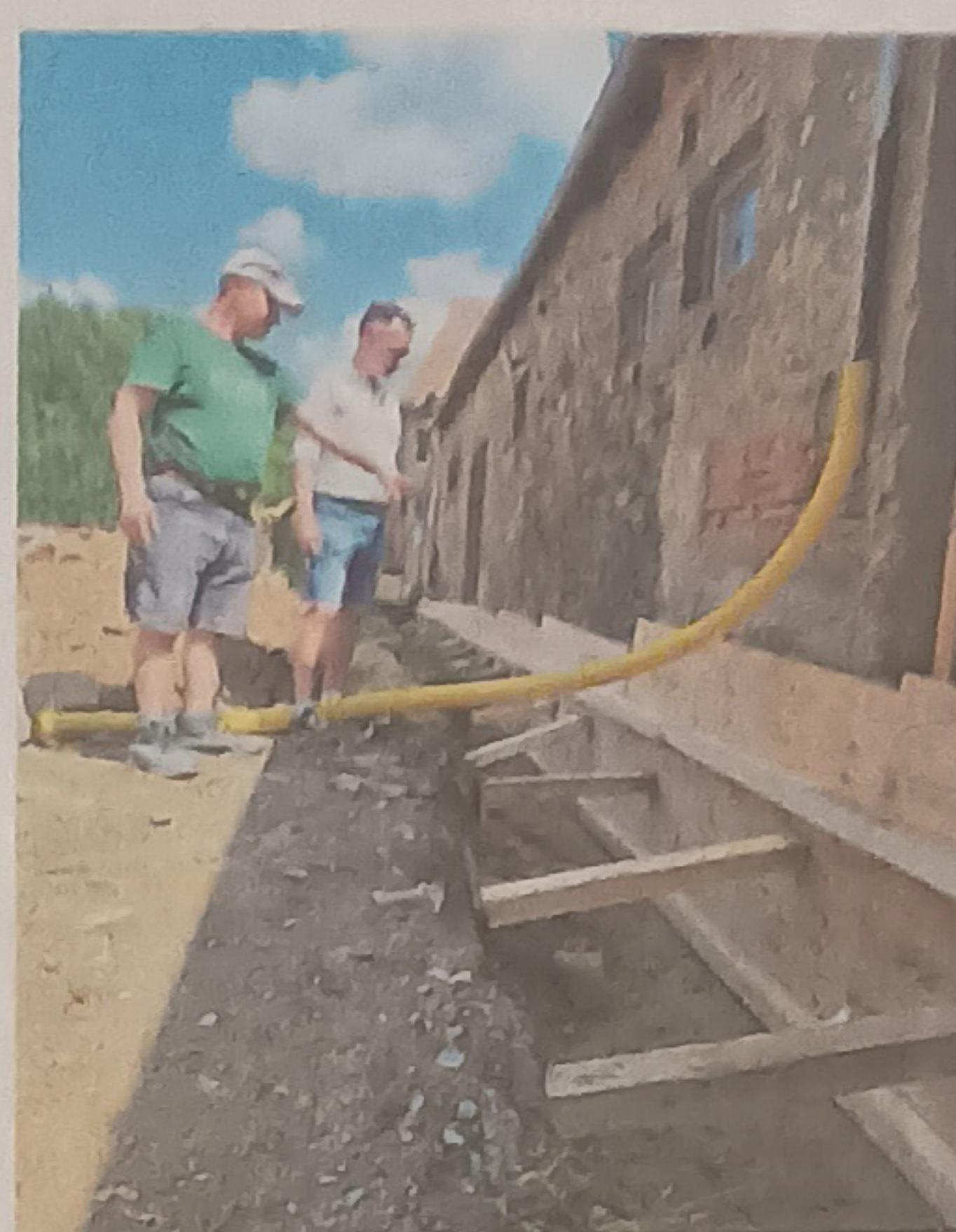
Thomas mit Brigade-Klempner Dima im Austausch über die geplanten Betonarbeiten.
